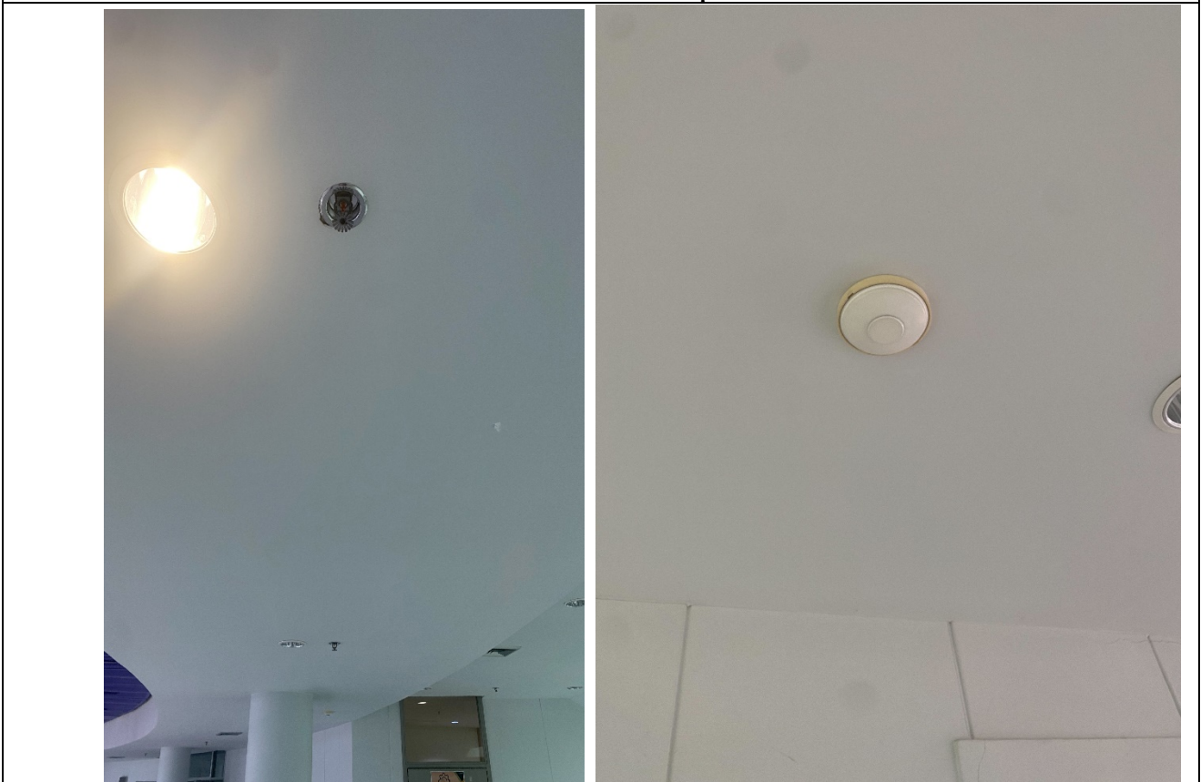
4. Automatic (Sprinkler Type)
